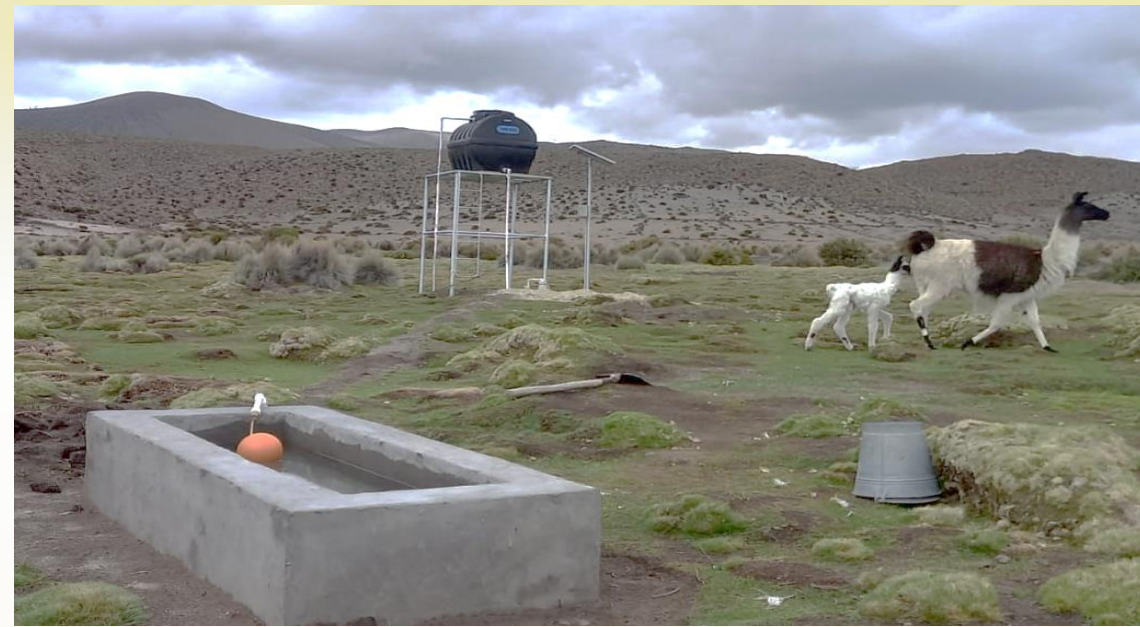
Sistema Fotovoltaico, Comunidad Distrito III de Chachacomani, Municipio Turco, Oruro
