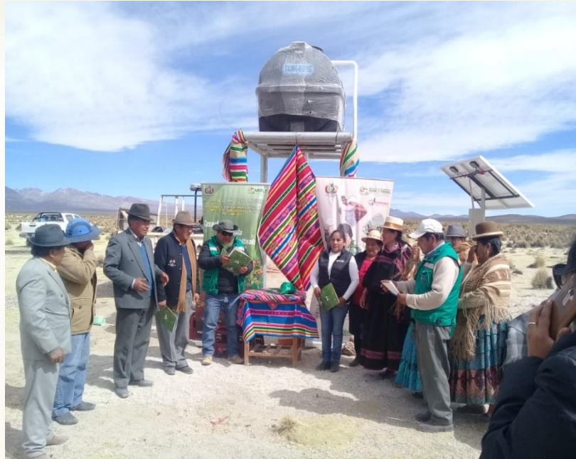
Sistema Fotovoltaico, Comunidad Bella Vista. Oruro
